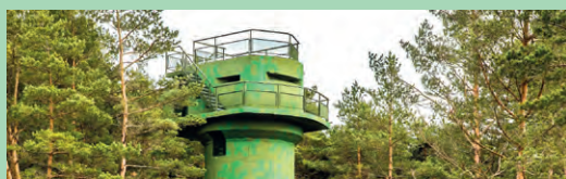
Башня коррекции наводки огня 46-й береговой батареи Вентспилса (34) 📍 Saulrieta iela 2, Ventspils (🕒 9.00 – 20.00)
