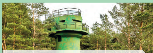
Ventspilio 46-asis pakrančių apsaugos baterijos ugnies reguliavimo bokštas (34)
